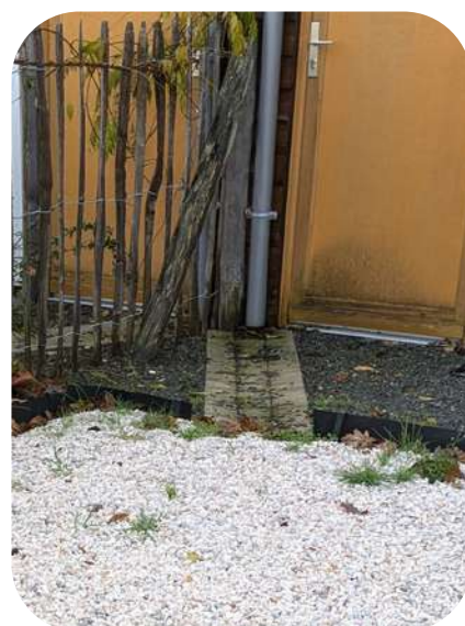
Ici, l'eau qui coule de la gouttière rejoint un espace gravillonné perméable.
